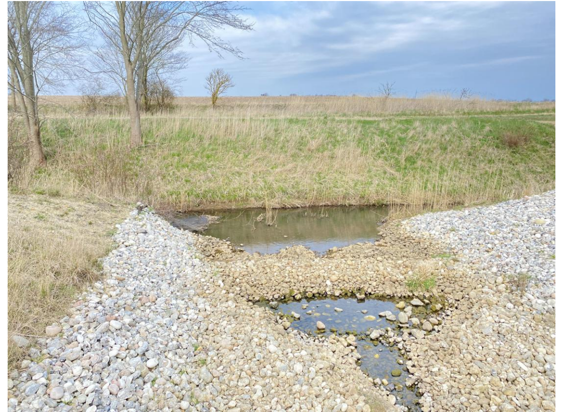
Overløbskant ved udløbet, der skal sikre at havørreder ikke søger op i søen.
